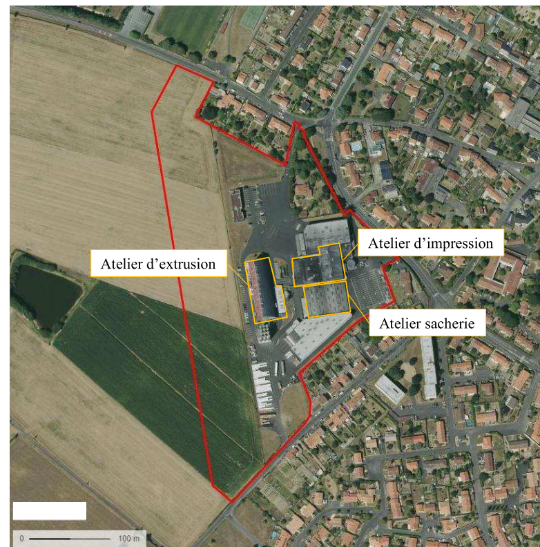
Figure 3 : Vue aérienne du site PALAMY au May-sur-Evre (49)
