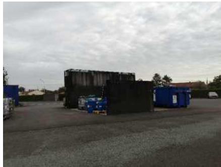
Stockage des déchets de produits inflammables, des boues d'encres, de fûts d'encres vides et d'huiles usagées (PC3 et PC5)
